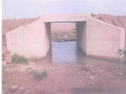
Se construyeron 2 alcantarillas sencillas de 36" de 6 ml: 1. En la vía sobre ramal, ye Bendición - Samán con coordenadas (e: 950794, n: 1079114); 2. via sobre ramal, Merey - Santa Hercilia con coordenadas (e: 931069, n: 1086116)
